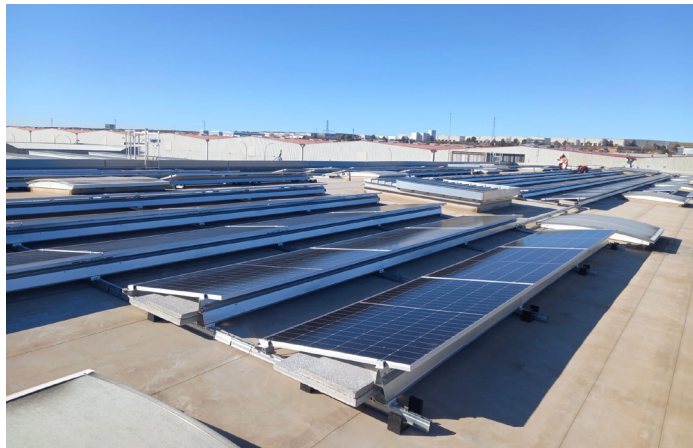
Paneles solares en el centro de Cabanillas de ILUNION Servicios Industriales
